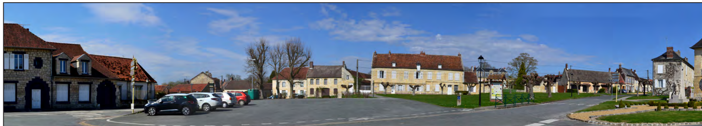
État initial - Vue panoramique
